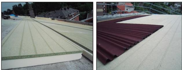
Su principal aplicación son las cubiertas compuestas por superficies continuas como: forjados de hormigón, cerámicos o de madera. Con su instalación, directamente sobre la superficie soporte de cubierta, se ahorra notablemente en tiempos de instalación y
