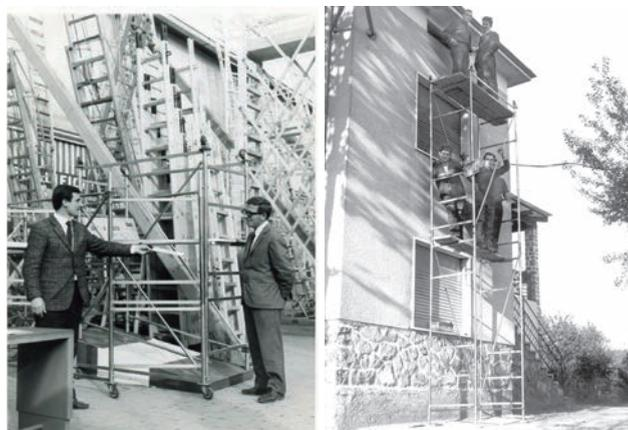
evitar la caída de objetos y de barandillas dobles de seguridad a la altura de media pierna y de cintura. Si la plataforma supera la altura de pies de 2.00 m se necesitan también los 4 estabilizadores orientables que aumentan la superficie de apoyo y por tanto la estabilidad del equipo.
