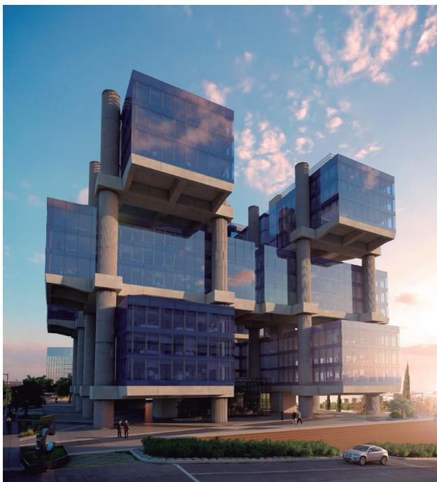
La fachada, realizada con el sistema Schüco FWS 60 SG, de alto desempeño térmico y acústico, ha sido fabricada e instalada por Carpintería Metálica Aluman S.L.
