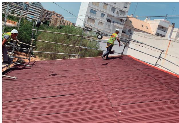
cuadrado al no requerir de tanto solape entre tejas. Por otro lado, la rugosidad de la parte superior de las placas asfálticas Onduline Bajo Teja DRS hace que las tejas curvas se retengan de forma natural, favoreciendo su agarre notablemente con la utilización de espuma de poliuretano, masillas adhesivas o incluso mortero de cemento y cal.
