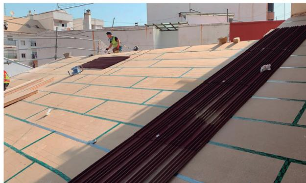
la empresa Serpa soluciones y gestión, expertos en rehabilitación de cubiertas y proyectos en madera, afectando a una superficie total de unos 300 m<sup>2</sup>. La cubierta presentaba diversas patologías como consecuencia principal de la falta de impermeabilización y, además, no contaba con ningún tipo de aislamiento térmico.
