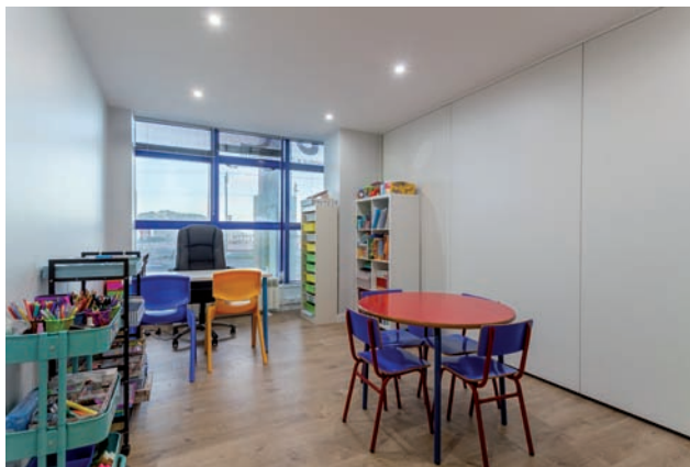
Una de las características del local es que se ha instalado un tabique móvil de 3 hojas, de suelo a techo, entre el aula de formación y el aula 3, para jugar con la capacidad de alumnos, pasando de 19 m 2 a 32 m 2
