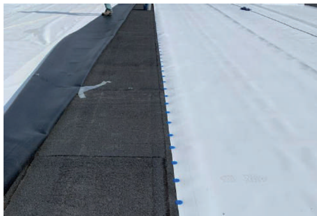
La instalación de una lámina de TPO aporta un sistema seguro, de elevadas prestaciones mecánicas
