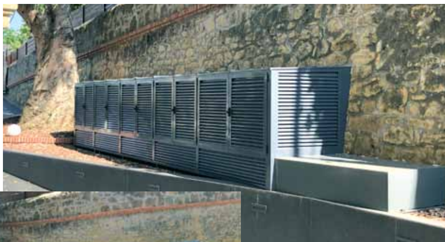
LA INSTALACIÓN CONSTA DE 5 BOMBAS DE CALOR.
