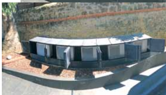
LA INSTALACIÓN CONSTA DE 5 BOMBAS DE CALOR.
