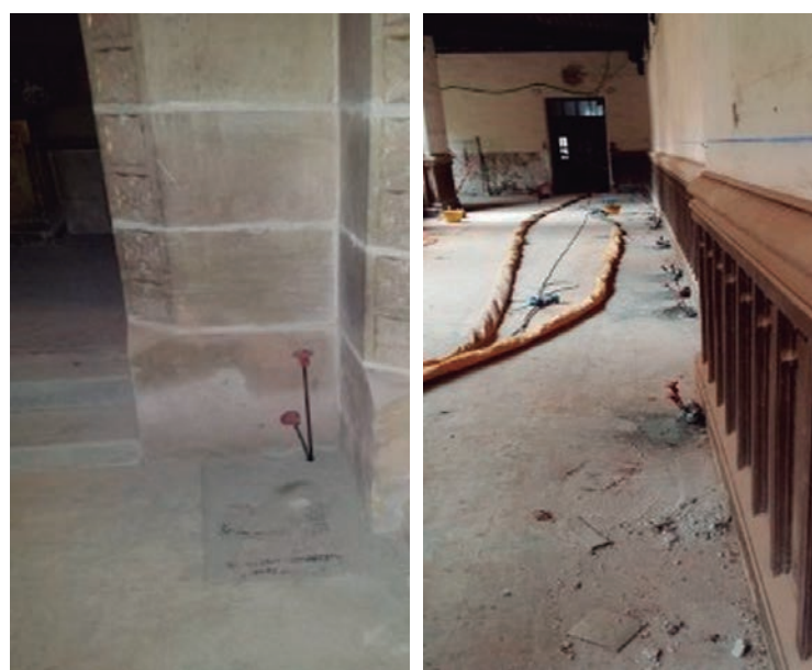
Figura 9 y 10. Tubos de inyección contrafuertes
