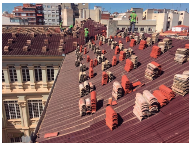
Arriba, rehabilitación de Onduline en el Parador de Toledo. Debajo, obras en las Escuelas Pías de Albacete
