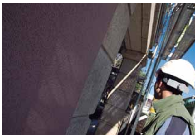
Las actuaciones deberán mejorar la calificación energética total del edificio en al menos una letra
