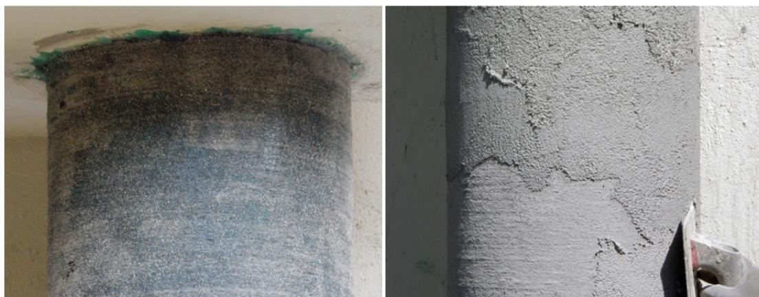
Espolvorear árido de sílice sobre la capa de Adhesivo Carbotech Impregnante para generar rugosidad.
