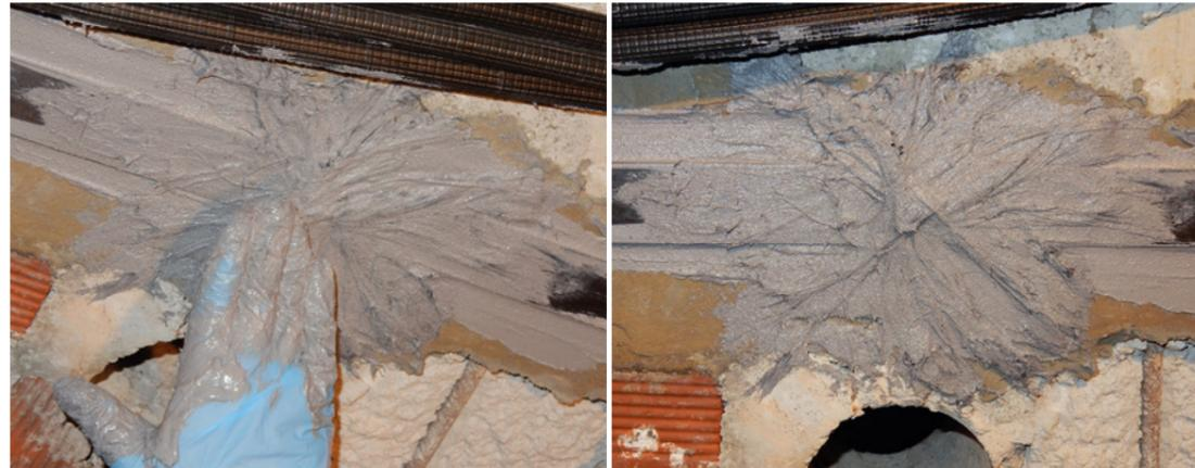
Extender y pegar las fibras de la zona flexible del Fiocco Carbotec
