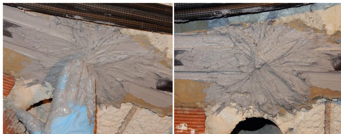
Extender y pegar las fibras del Conector Carbotec
