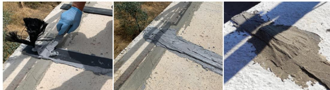
Colocar el Fiocco Carbotec en el extremo del laminado, previa realización y limpieza de la perforación.\*
