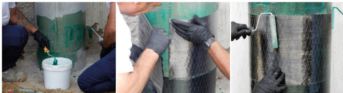
Aplicar el Adhesivo Carbotech Impregnante sobre el soporte con un rodillo de pelo corto.
