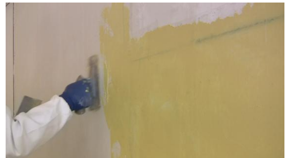
Aplicación sobre cartón yeso imprimado con Sika Top 50
