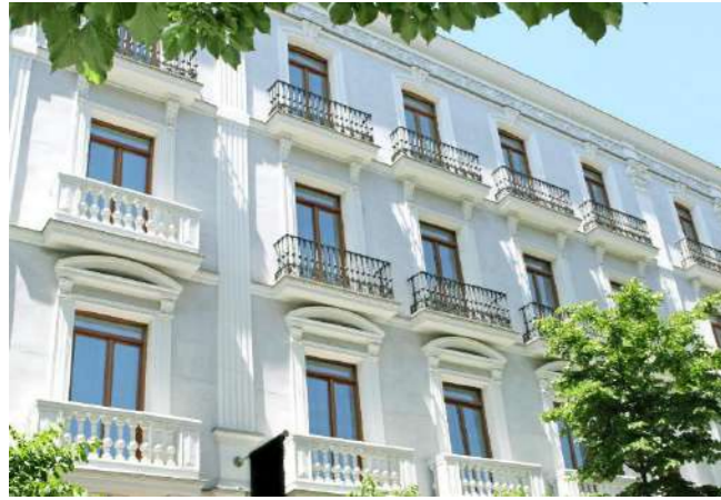
Rehabilitación Integral de Edificio C/ Claudio Coello nº 67 (Madrid) – HOTEL ÚNICO
