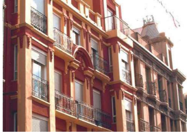
Rehabilitación Integral de Edificio C/ Miguel Fluiters en Guadalajara
