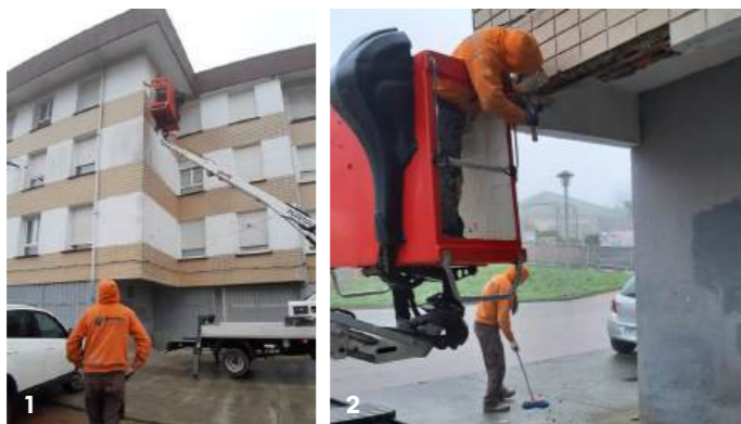
Fotos 1 y 2 Inicialmente con cesta elevadora, se pican las zonas que están abombadas y tienen riesgo de caerse para evitar deteriorar ventanas.
