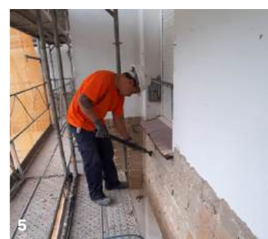
Fotos 5, 5 A Se pican las zonas de fachada que están deterioradas, posteriormente se rasearán para asegurar que los anclajes del Sate tienen un buen soporte.
