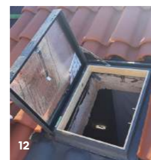
Fotos 12, 13 y 14 Los aleros son tratados de una manera diferente en cuanto a impermeabilización, respecto de la cubierta también se colocan las ventanas como traga-luces.
