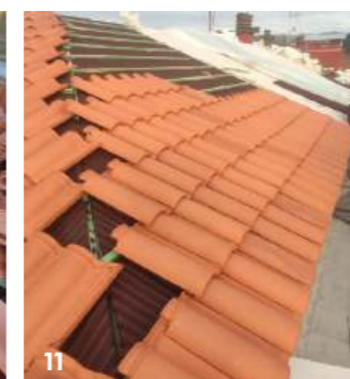
Fotos 8, 9, 10 y 11 Según se avanzan los trabajos de la cubierta se van colocando toldos, para evitar en la medida de lo posible que entre agua, aunque nunca se puede asegurar porque también el viento actúa a la hora de meter agua y provocar filtraciones.
