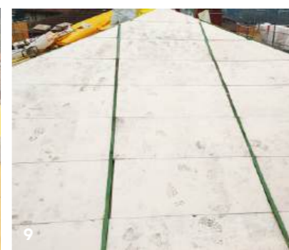
Fotos 7 A Se van colocando las diferentes capas del sistema Sate.
